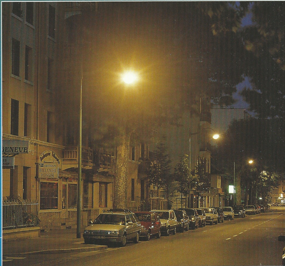
Anney : Eclairage réalisé avec les lampes Sodium Haute pression
