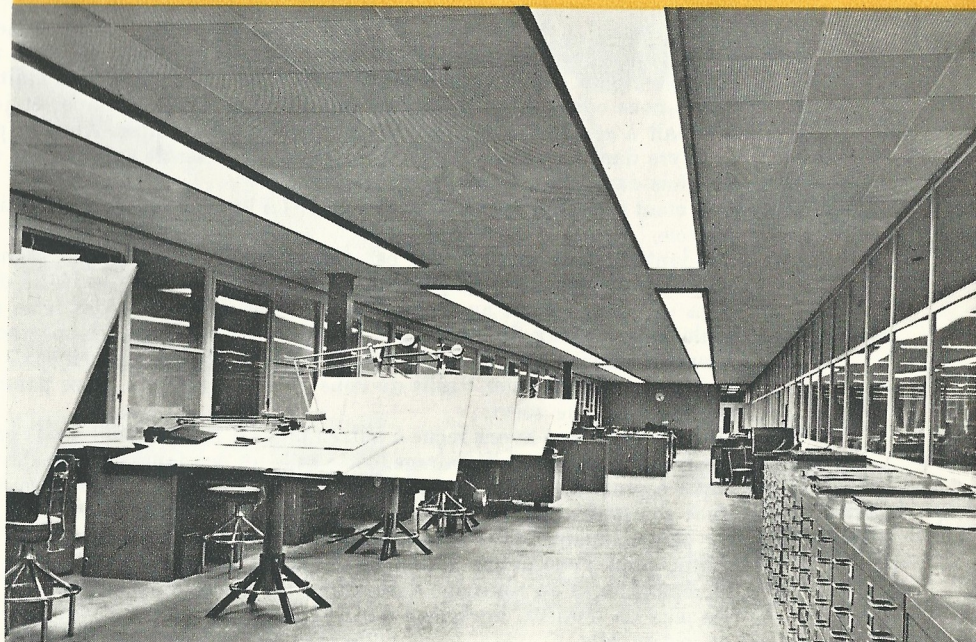
BUREAU D'ÉTUDES ET BUREAU COMMERCIAL. Les réflecteurs RFD 265 sont ici logés dans le plafond insonorisé — Le défilement des lampes qui sont du type TF 65 en « Blanc Brillant de Luxe » est obtenu par une verrerie striée Holophane. Niveau d'éclairage moyen dans le bureau commercial : 350 lux.
